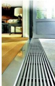
**Balkon nur über Stufe zu erreichen. Lösung:** Fenster und Türen bodengleich einsetzen.
